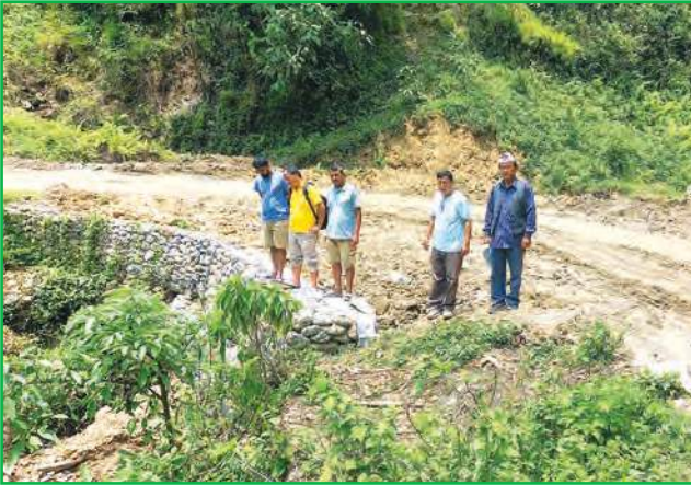
माई न.पा. वडा नं. १ र ३ को भिमसेन र तिनदोभाने खोल्सिमा ग्याबिन सुरक्षा व्यवस्थापन कार्य
